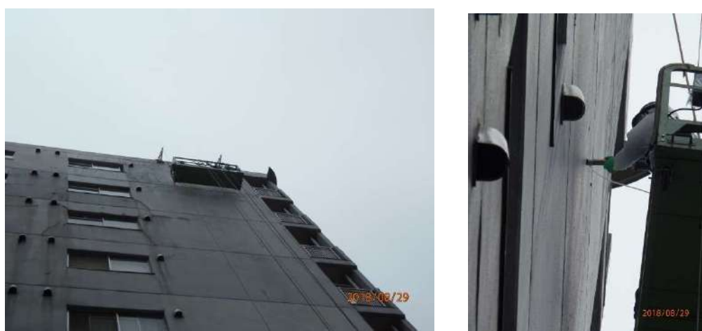
写真6. 8 ゴンドラによるマスク A 除去作業
