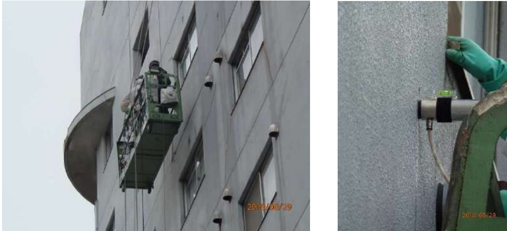
写真6. 9 ゴンドラによるマスチック A 仕上げ外壁の穿孔作業
