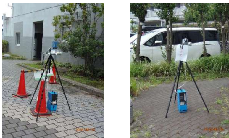
写真6. 7 施工区画周辺の測定点
